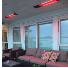
埋め込み設置
